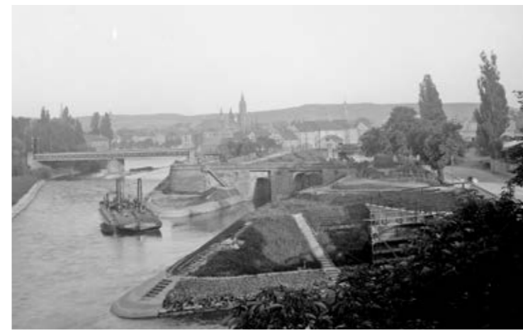
Schleusentore Wilhelmskanal mit Einfahrt in den Winterhafen vorne rechts, 1920. Foto: Wilhelm Kratt (I)
